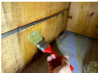
Abgeflamnte, aufgeraute Beutenwand mit gesiebter Lösung bestreichen
